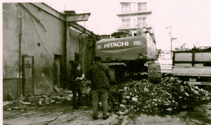
名古屋市内の解体現場を調査
